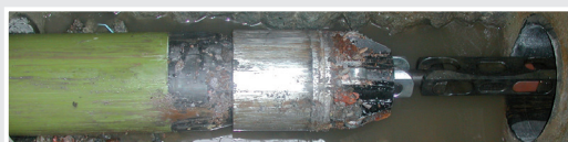
Paso entre arquetas intermedias.
