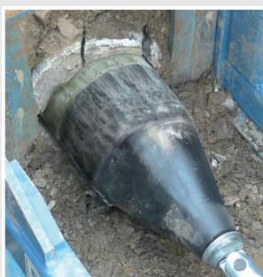
La tubería llega a la cala de llegada.
